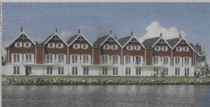
Domy wybudowane przez Kristensen Group w Danii
